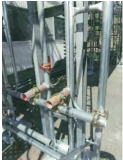
ガイドレールを横地パイプに クランプ付パイプで取付
