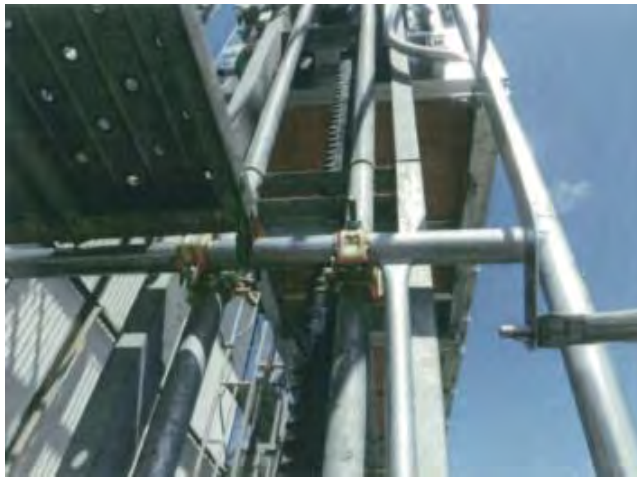
ガイドレールと杵組足場横地に クランプにて直接取付
